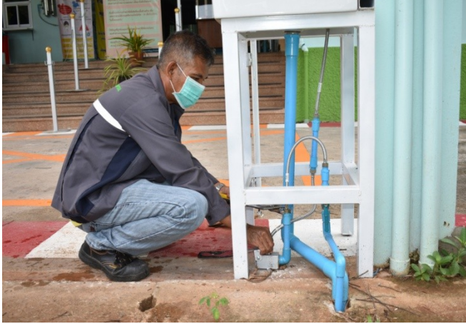
5. นำชุดอุปกรณ์ที่ประกอบไว้ไปติดตั้งกับอ่างล้างมือ
