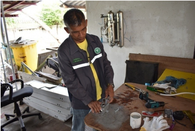
1. นำวาล์วน้ำมาติดตั้งกับฐานยึดพื้น
